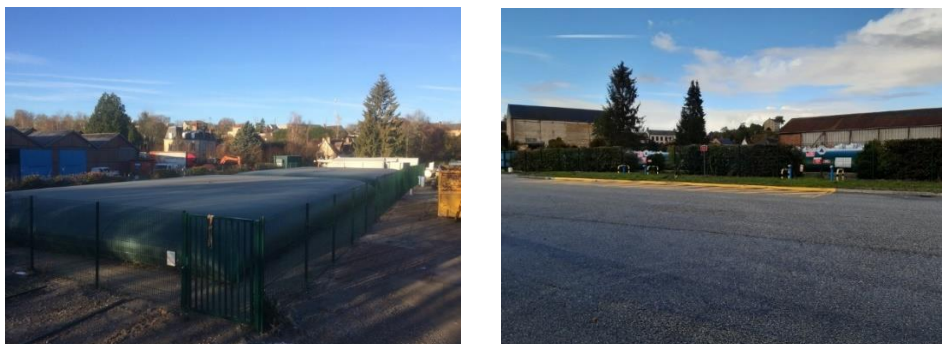
FIGURE 9 : PHOTOS DES 2 RESERVES D'EAU DE 450 M 3
